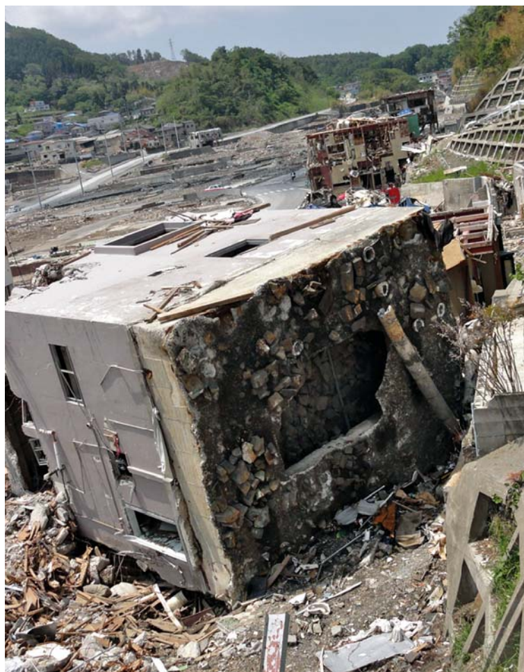
Durante el tsunami de Japón del 11 de marzo de 2011, olas con una profundidad superior a los 10 m alcanzaron una velocidad de 6 m por segundo derribando y arrastrando edificios de tres plantas a casi 50 m de distancia. Onagawa (Japón). Fotografía por cortesía del ITIC.
