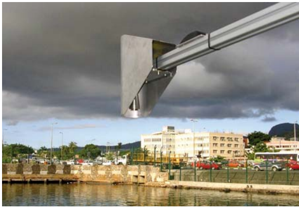
Las estaciones del nivel del mar GLOSS emplean muchos instrumentos para medir el nivel del mar, incluyendo radares invertidos. Port Louis (Mauricio). Fotografía por cortesía del Centro del Nivel del Mar de la Universidad de Hawái.
