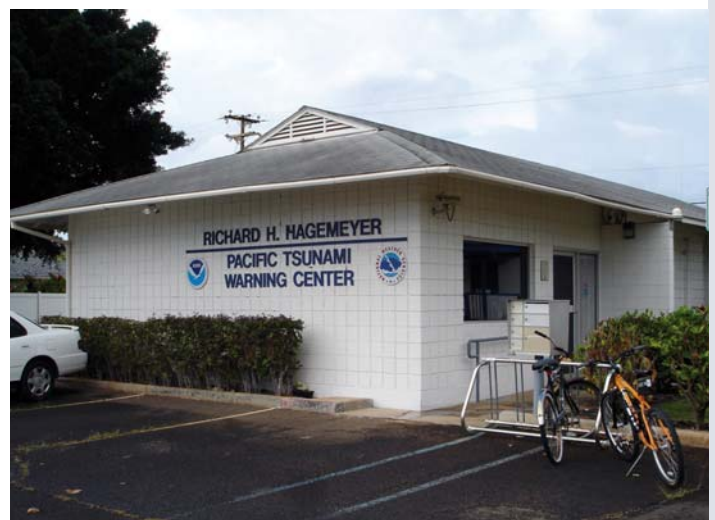
Instalaciones del Centro de Alerta contra los Tsunamis en el Pacífico (PTWC) localizadas en Ewa Beach (Hawái, EE.UU.).
