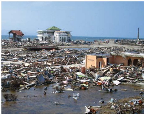
El tsunami del 26 de diciembre de 2004 destruyó la ciudad cercana a Banda Aceh (Indonesia) dejando sólo unas pocas estructuras en pie. Fotografía por cortesía de Yuichi Nishimura, Universidad de Hokkaido (Japón).
