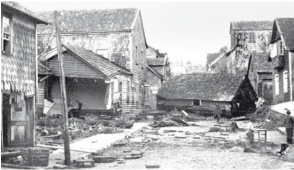
Daños causados por el tsunami en Chile, 22 de mayo de 1960. Fotografía por cortesía de la Ilustre Municipalidad de Maullín (Circular 1187 USGS).
