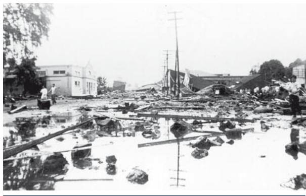
Destrucción en los muelles de Hilo (Hawái) ocasionada por el tsunami transpacífico generado mar adentro de la isla de Unimak (islas Aleutianas, EE.UU.) el 1 de abril de 1946.
