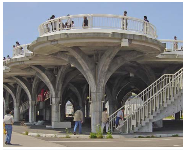
Plataforma elevada utilizada como mirador turístico y para la evacuación en caso de tsunami, isla de Okushiri (Japón). Fotografía por cortesía del ITIC.
